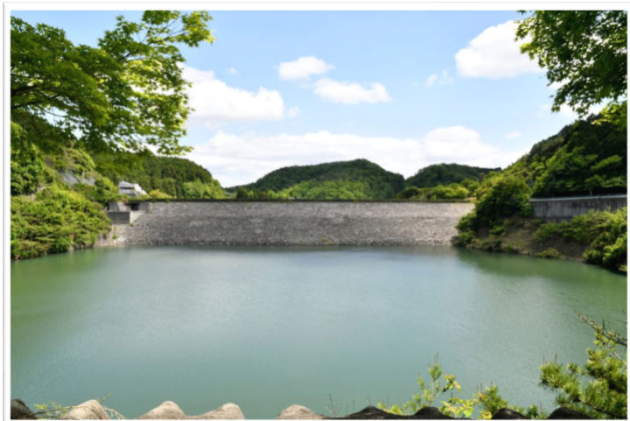
1983年に完成した箕面川ダム（治水ダム）
