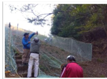
防鹿ネット設置
