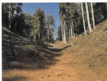
《流木対策工》危険木除去
