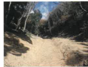
《流木対策工》危険木除去
