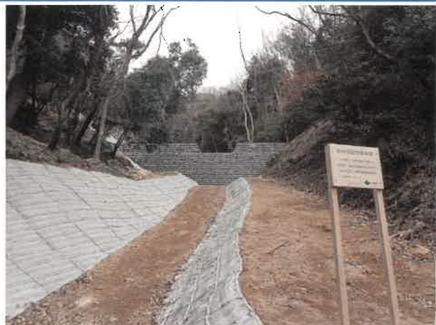
治山ダム施工後(新稲)
