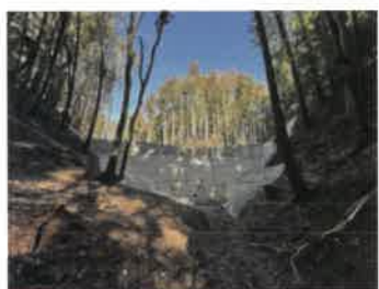
《治山ダム》施工後
