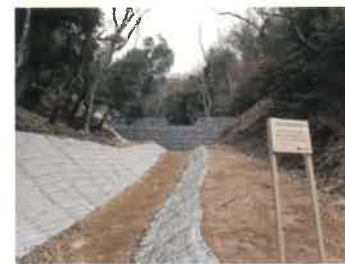
《治山ダム》施工後
