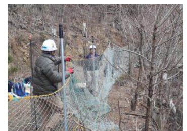
3/9 防鹿ネット新設
