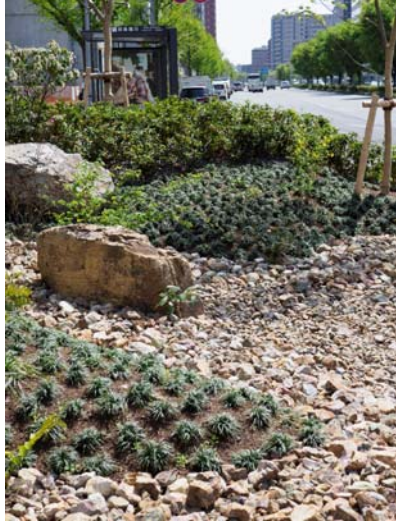
雨水貯留浸透機能を備えた植栽帯（左札幌市 右京都市）
