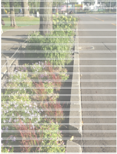
雨水貯留浸透機能を備えた植栽帯（左札幌市 右京都市）
