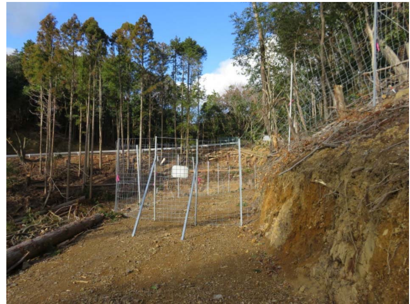
シカ害防護柵を設置
