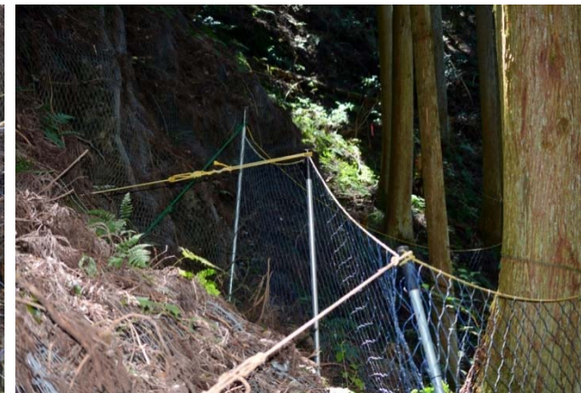
ポール交換/ロープで補強
