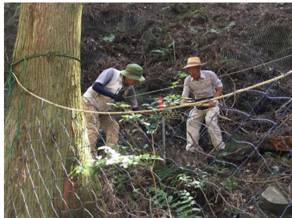
ポール交換作業中
