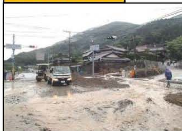
水路閉塞による国道通行止 H26年8月(箕面市)
