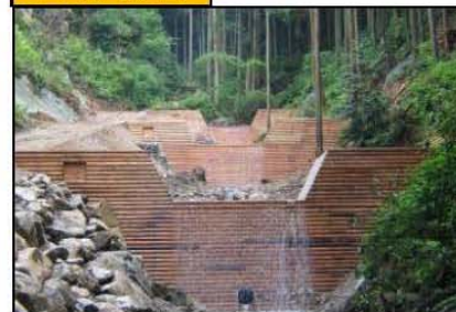
治山ダムの設置により、溪流勾配を 緩和し土石流の発生を未然に防止
