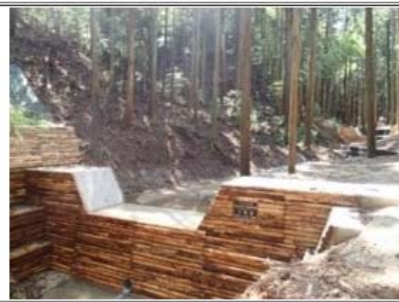
1. 治山ダムの整備
