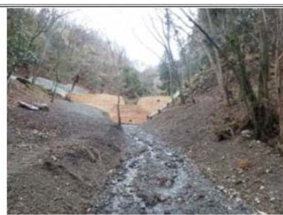
2. 危険木の除去
