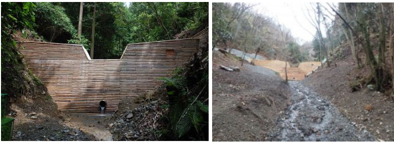
治山ダムの整備
