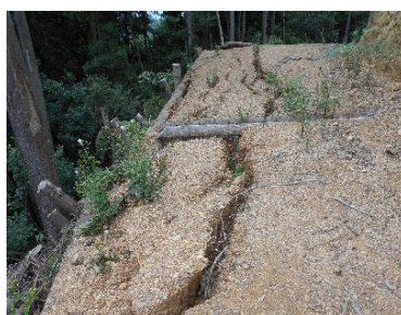
作業道の崩れ(2022年9月8日)⇒対策実施(9月21日)
