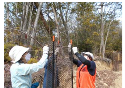
防鹿ネットの設置
