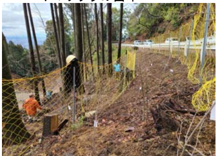
防鹿ネットの設置
