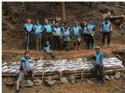
オヶ原池から谷山谷への分岐点近く、溪流沿いのハイキング道が大雨の影響により崩れました。こちらも箕面市が担当すべき里道ですが、手が回らないようです。日ごろ、自転車を利用しての箕面マウンテンバイク友の会の皆さんが、杭を打って、土嚢を積むなど、山道補修の応急処置をしました。
