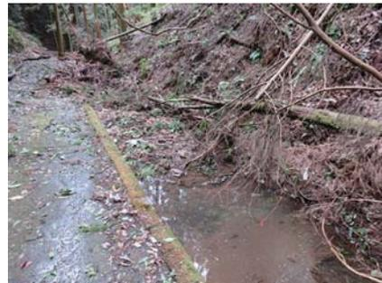
ウツギ谷は、昨年10月と同様に、溪流沿いのスギ・ヒノキの倒木が多く、歩く事が出来ない状態になりました。道路のえぐれを放置しておく、更に道が崩れる恐れがあります。箕面市が水路の倒木や土砂を撤去するなど、林道の復旧のための早急な対応が必要になっています。
