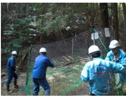
シカ害から守る植生保護柵の設置
