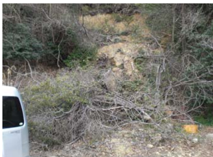
山林所有者所有地の土砂崩れ
