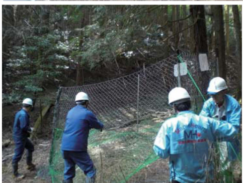
シカ害から植生を守る保護柵の設置
