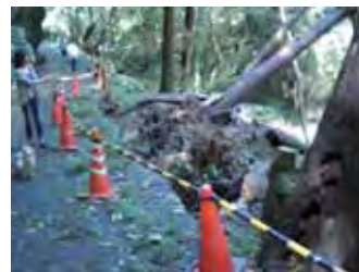
唐人戻り岩前 滝道の崩落
