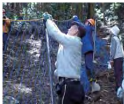
防鹿柵の設置
