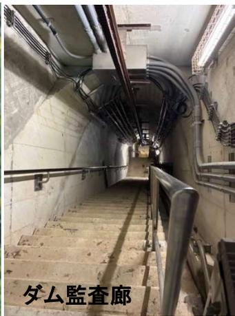
高低差約50m、堤防の底に設置されている管理用通路
