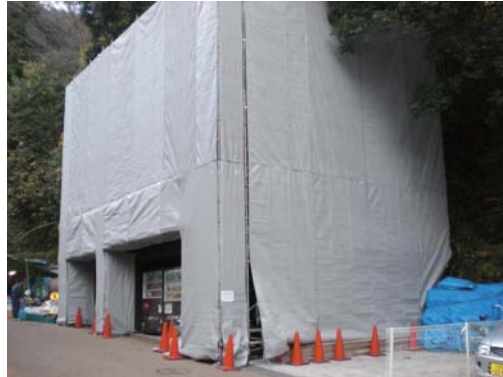
工事中の様子
