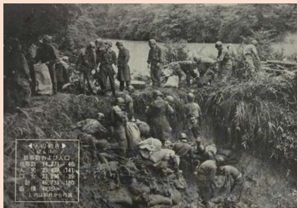
西坊島の導心ヶ谷池の堤防に土のうを積んで、決壊を必死に くいとめる自衛隊員※昭和42年「広報みのお」7月号から転載
